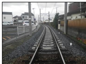
田中口～日前宮間 竣工後
