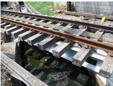
施工後（津秦第1橋梁）
