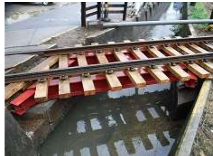
施工後（吉礼第1開渠）
