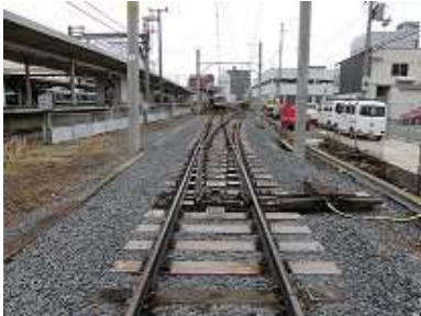
施工後（和歌山構内）
