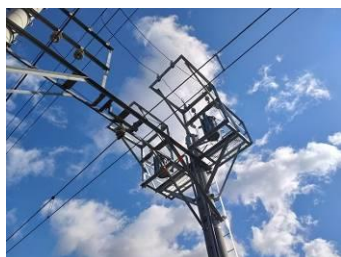
伊太祈曾～山東間 電源設備更新 竣工後
