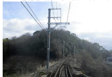
山東～大池遊園間 支持物更新 竣工後
