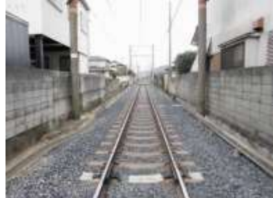
施工後（田中口～日前宮）
