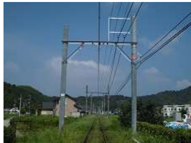
施工後（吉伊40号柱）
