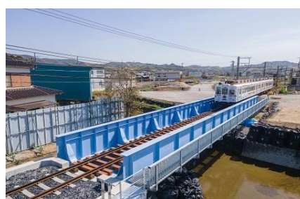
平尾第1橋梁（竣工）
