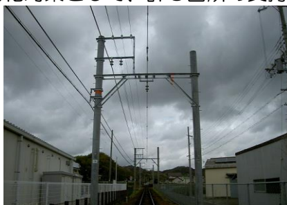
施工後（吉伊40号柱）
